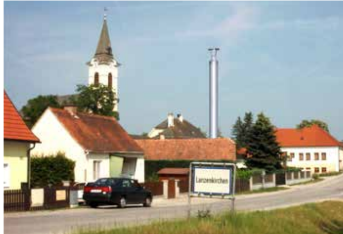
Kein schöner Anblick: Nirosta-Turm des neuen Heizwerkes neben der Lanzenkirchner Kirche: So hätte es ausgesehen!
