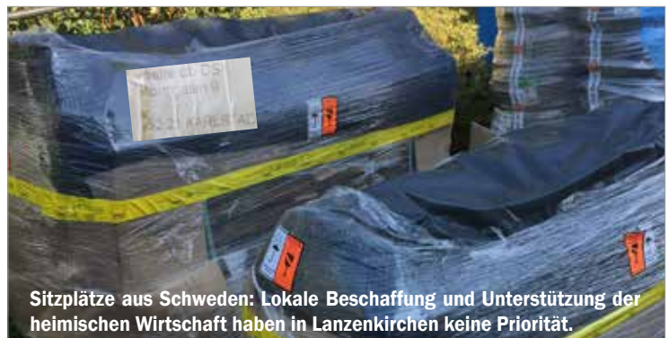
Brunnen aus Spanien - hier noch gut verpackt. Da die Höhe der Verbauung nicht stimmt, wird der Brunnen nochmals ausgegraben.
